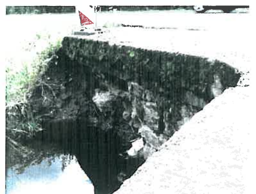
Obr. 7 Propustek č. 1 ústí na pravé straně ve směru Přimda – Rozvadov zneprůchodněný bobří hrází
